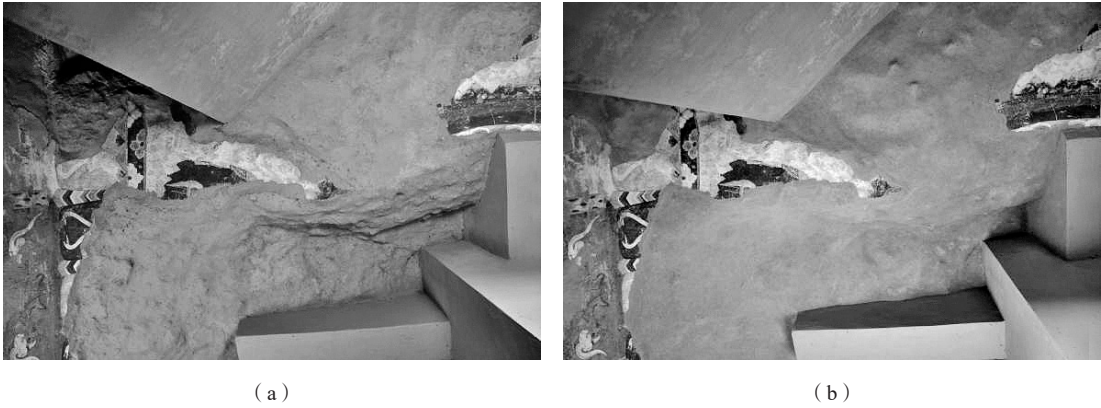
图4 第5窟主室顶部协调处理加固效果 (a) 主室东侧顶部柱南协调处理加固前；(b) 主室东侧顶部柱南协调处理加固后
