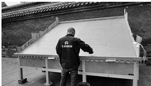
图15 抹油灰护板灰 (左: 新型细泼灰; 右: 生石灰粉)
