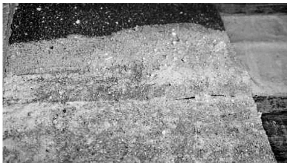
图13 油灰护板灰与高丽纸条连接位置局部开裂
