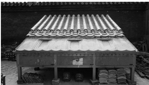
图16 局部揭露至油灰护板灰层
