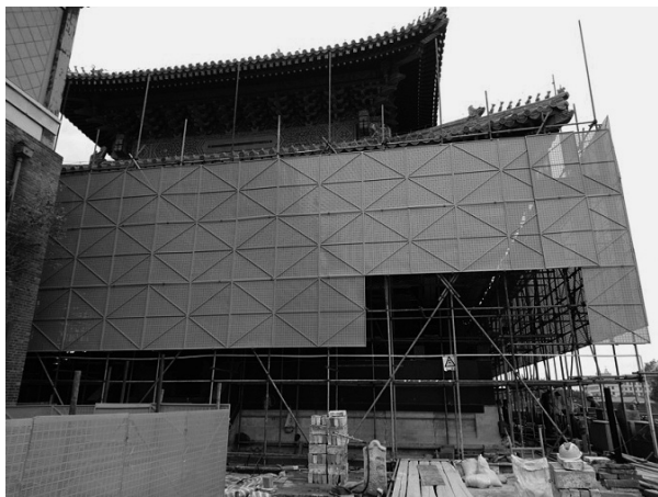
图14 施工中的西华门
