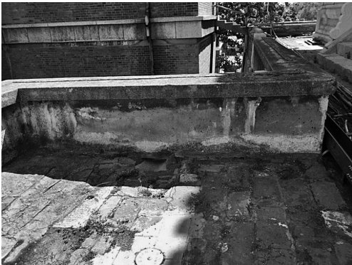
图6 混凝土砌筑的现代宇墙
