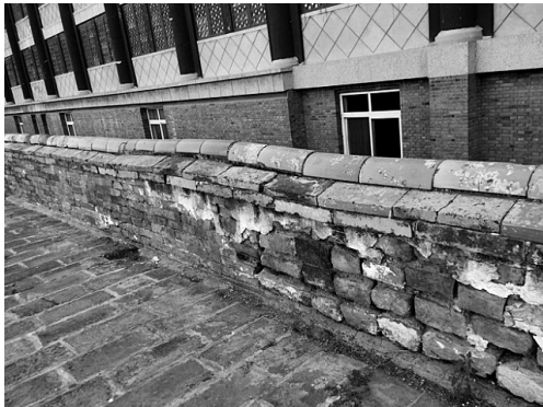
图7 城台北侧原马道位置糙砌宇墙
