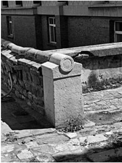
图9 原马道西侧宇墙角柱石
