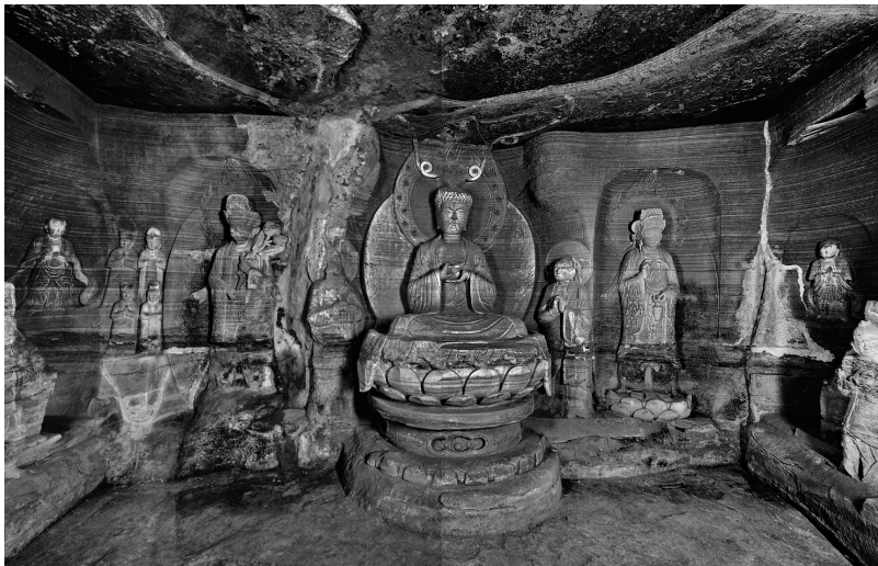
图5 北山石刻136窟正壁岩体水害
