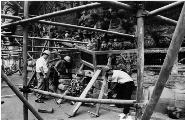
图8 错位变形岩体归位加固
