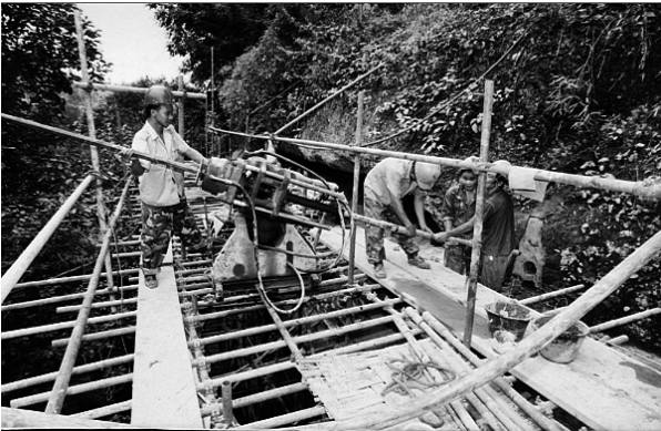
图7 大型锚杆锚固危岩体
