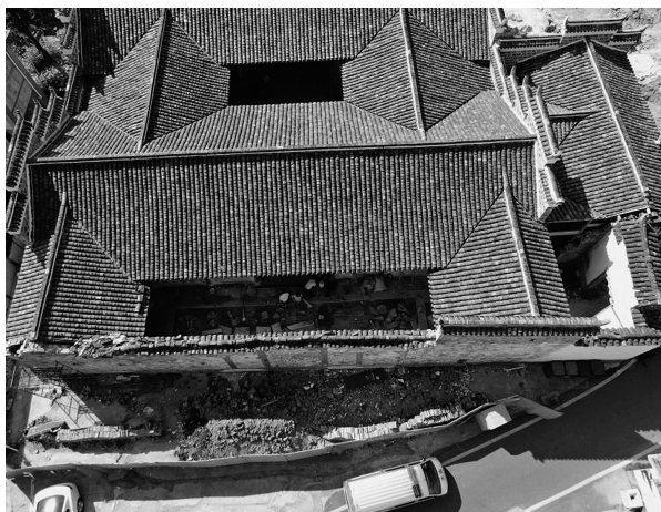
图6 东墙和正堂的航拍图像
