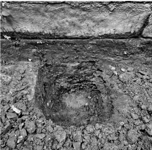
图16 南墙外侧下部的红色条石基础
