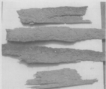
图6 木构件的腐蚀样品
