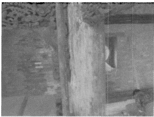
图4 表面褪色、剥落图
