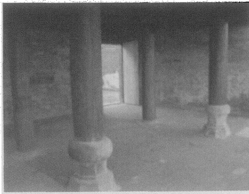
图 20 红漆木柱保护修复后效果
