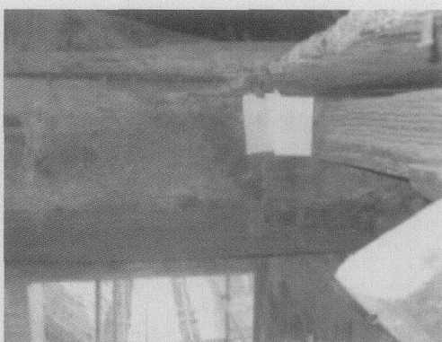
图8 戏楼内梁上黏附的报纸, 木材炭化
