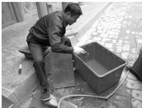
图 15 用毛刷蘸着溶液在瓦件表面刷 1 ~ 2 遍
