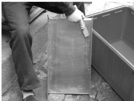
图 16 用黄铜刷刷瓦件表面
