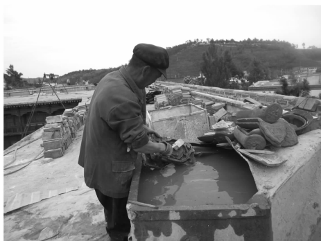
图 16 审瓦、清洗及浸泡瓦件
