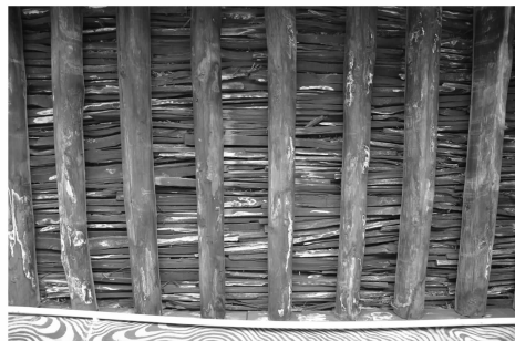
图3 用栈棍铺的木基层
