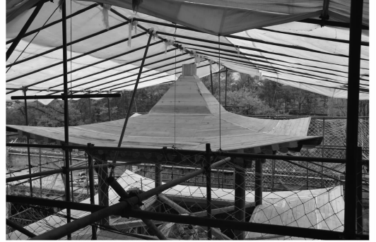
图 13 横着铺望板的方法
