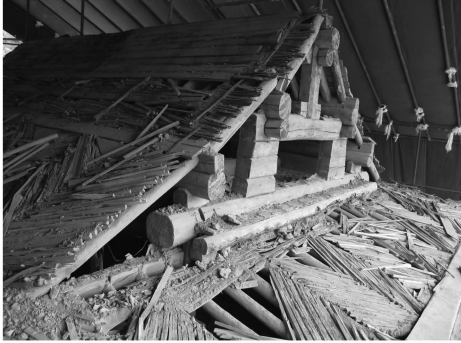
图 12 栈棍人字形铺装方法
