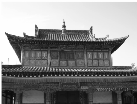
图 10 遍知殿琉璃瓦屋面
