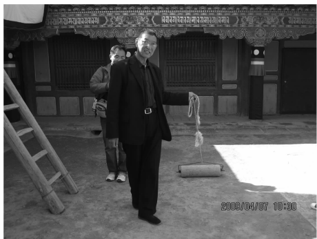
图 8 工作人员拉着石碾子碾压屋顶
