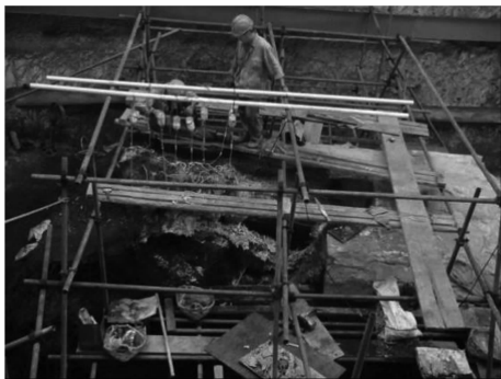
图1 滴灌加固树皮层
