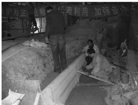
图 7 北墓道南侧夯土墙补配
