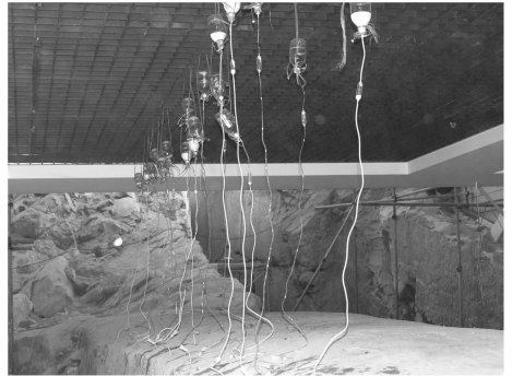
图 5 滴注法加固夯土
