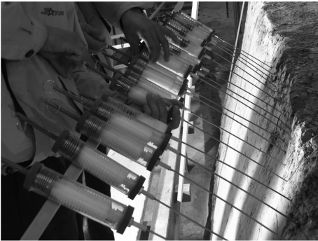
图 4 弹簧针管压力注射法加固夯土
