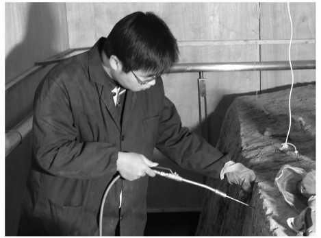
图 3 夯土墙深层加固
