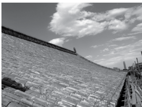
图1 端门前坡避雷带
