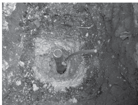
图2 接地极安装
