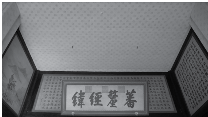
图1 建筑内檐糊饰后的棚壁
