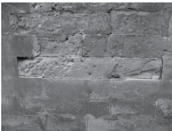
图18 修复前的兆祥所干摆墙面砖
