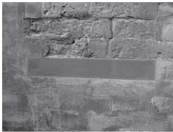
图19 修复后的兆祥所干摆墙面砖
