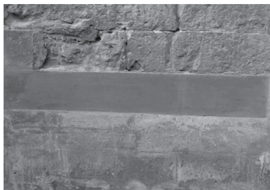
图17 干摆砖面使用灰板后的效果
