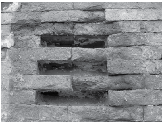
图22 修复前的东华门城墙
