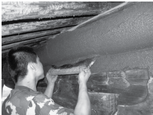
图15 檐檩做通灰所用的灰板
