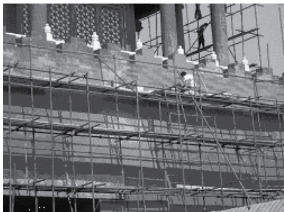
图25 修复后的东华门城墙
