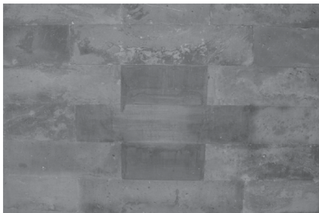
图28 西华门外南城墙修复后
