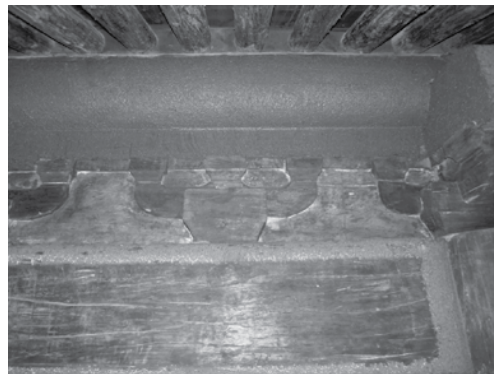
图16 檐檩通灰层使用灰板后的效果
