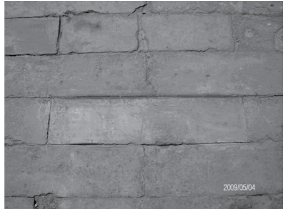
图21 修复后的衍祺门外地面砖
