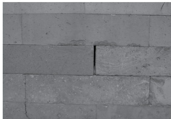
图7 太和殿东山墙下碱干摆砖打磨后露出灰缝
