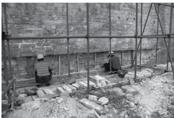
图8 英华殿院墙鼓闪进行局部拆砌维修
