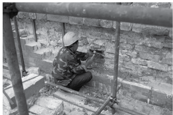
图9 英华殿院墙鼓闪进行局部拆砌维修
