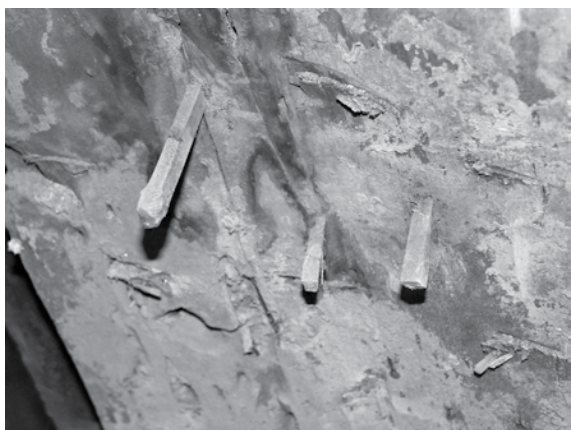
图5 彩塑支撑体上竹钉
