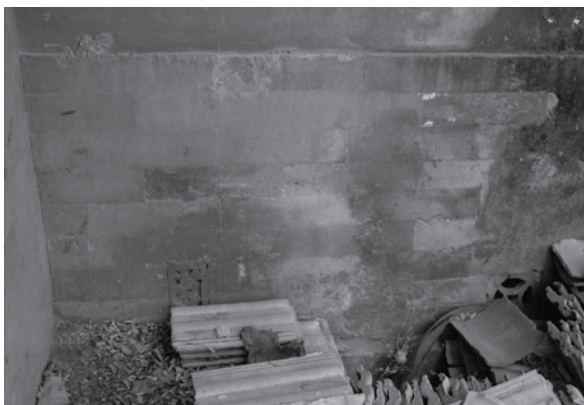
图4 英华殿西耳房东稍间后檐下肩排烟口
