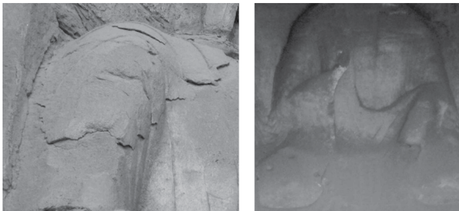
图7 文物现场粉尘沉积实例
