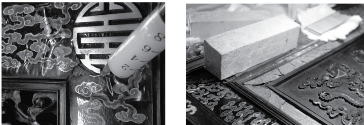
图6 注胶与压金属块处理
