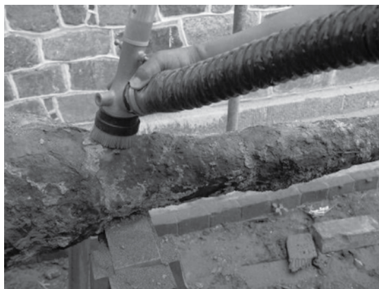
图4 喷砂除锈中
