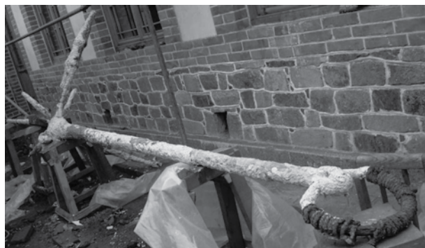
图5 5#铁锚涂敷脱盐
