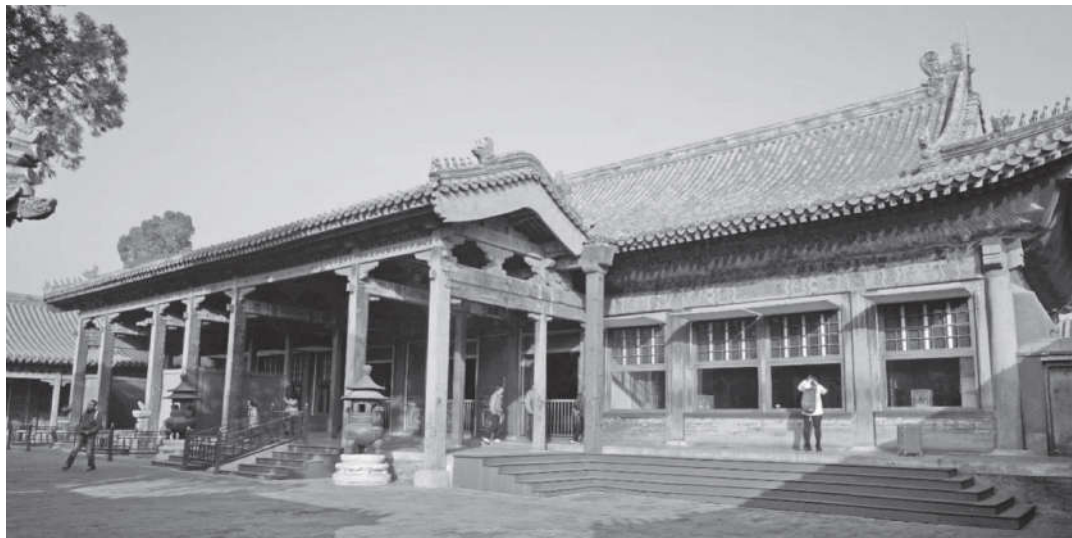
图1 养心殿正殿外景
