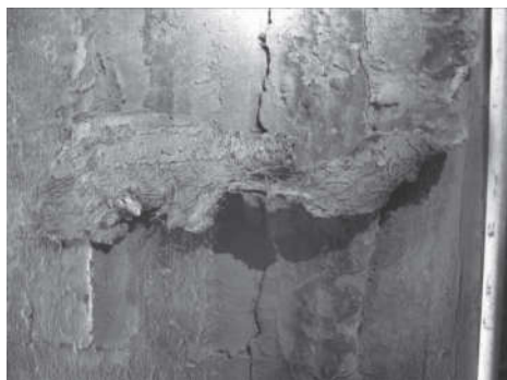
图13 启圣殿明间前廊内檐(麻灰地仗)
