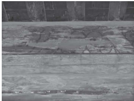
图10 快睹门北次间檐檩(衬底地仗)
