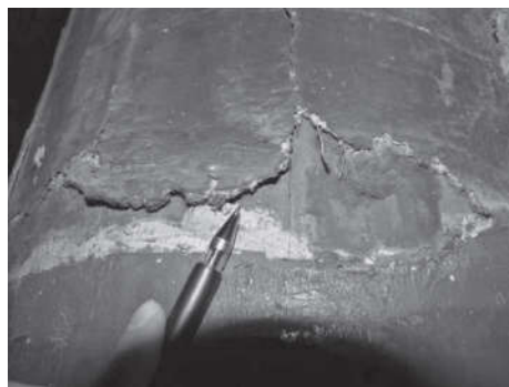
图14 金丝堂内檐明间西缝金柱柱头
