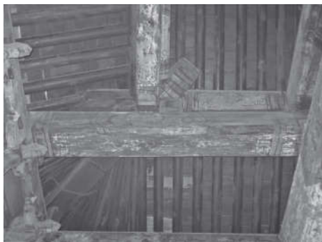
图19 弘道门东梢间前檐随上金檩枋底
