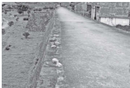
图9 苍南蒲门所城顶部三合土防水层
