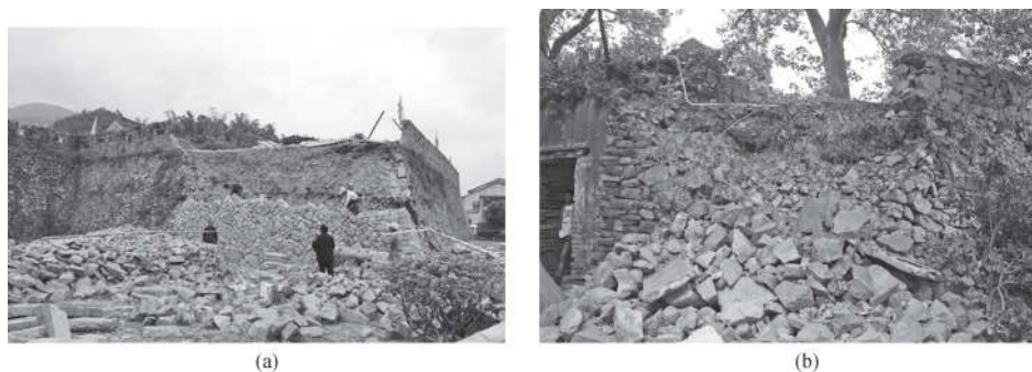
图8 古城墙局部坍塌 (a) 苍南蒲门所城东瓮城；(b) 临海桃渚城东瓮城
