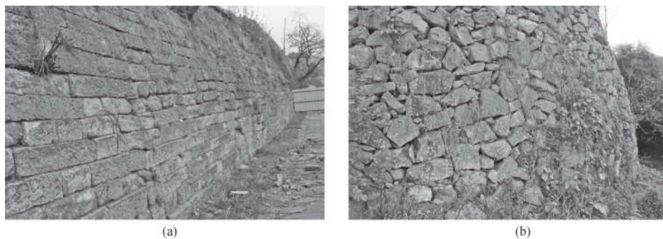
图6 局部向外黧闪 (a) 镇海后海塘城墙；(b) 临海桃渚城东城墙
