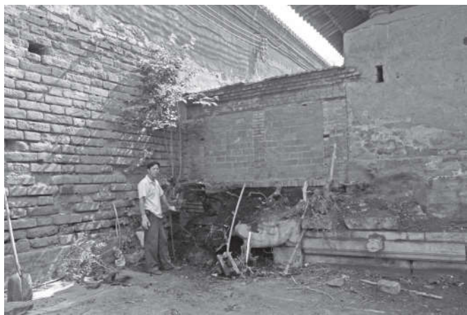
图8 乾元阁北临建房插入建筑墙体，堆煤渣，其中埋琉璃瓦
