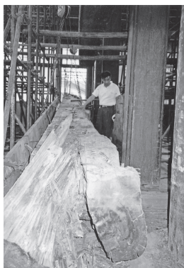
图12 修缮前武英殿大梁
