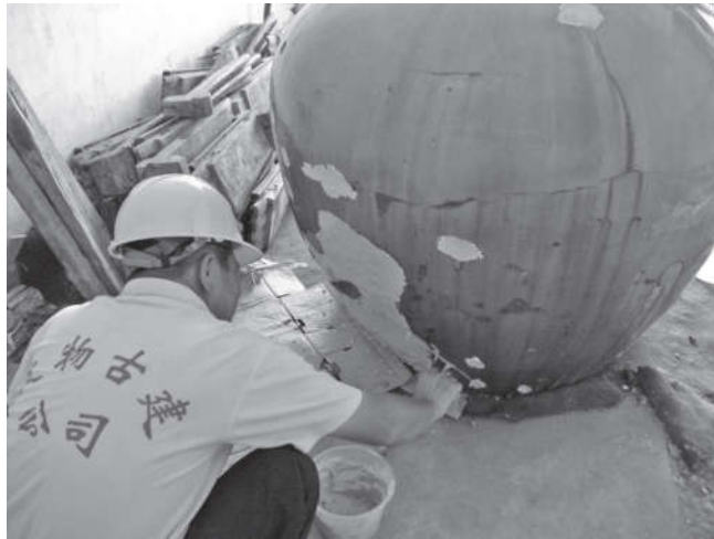
图20 修复宝顶残损
