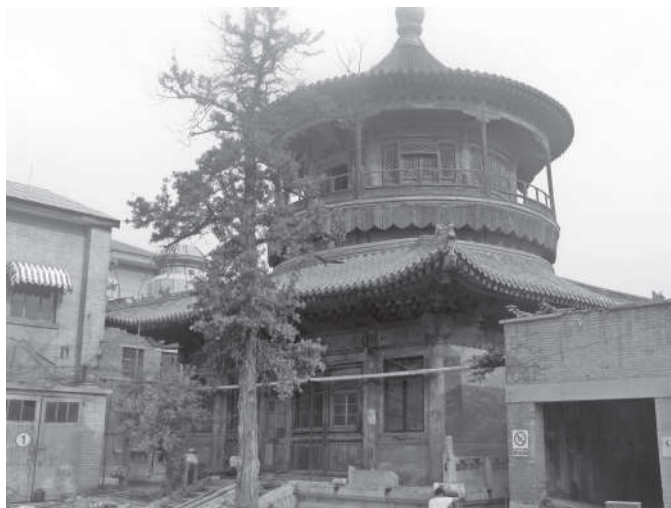
图24 乾元阁修缮前全貌
