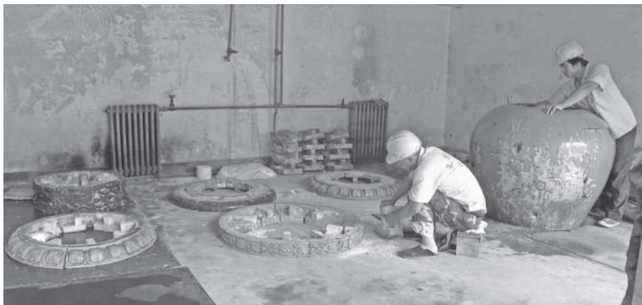
图19 按顺序码放宝顶构件
