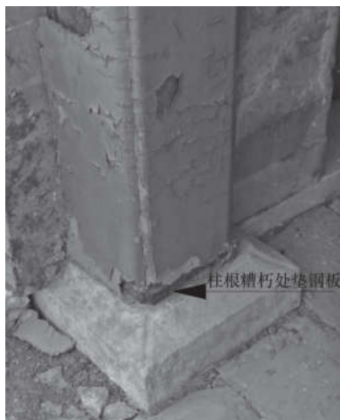
图1 钢板衬垫柱根
