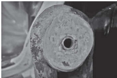
图23 利用4-6-S1断臂原来锚孔安装套管
