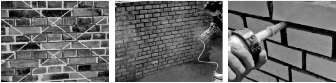
图2 置换砂浆部分工艺过程图
