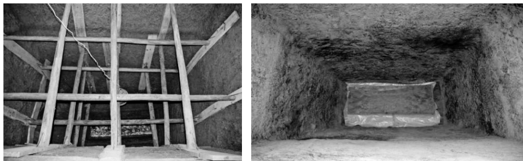
(a) 化学加固前(墓坑边坡临时支护)
