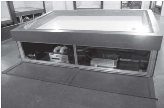
图4 山东博物馆10展厅展柜内恒湿模块示意图
