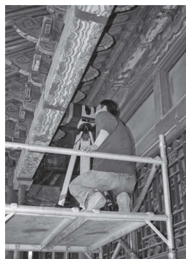
图8 三维激光扫描现场
