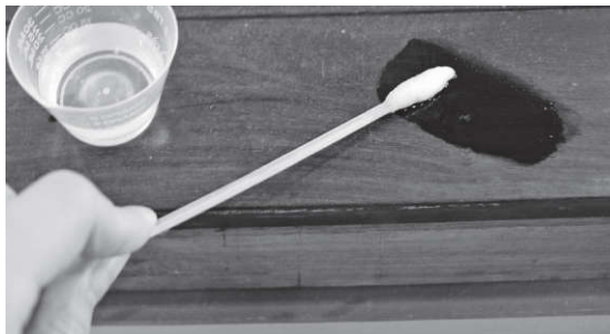
图23 TAC溶液清洗
